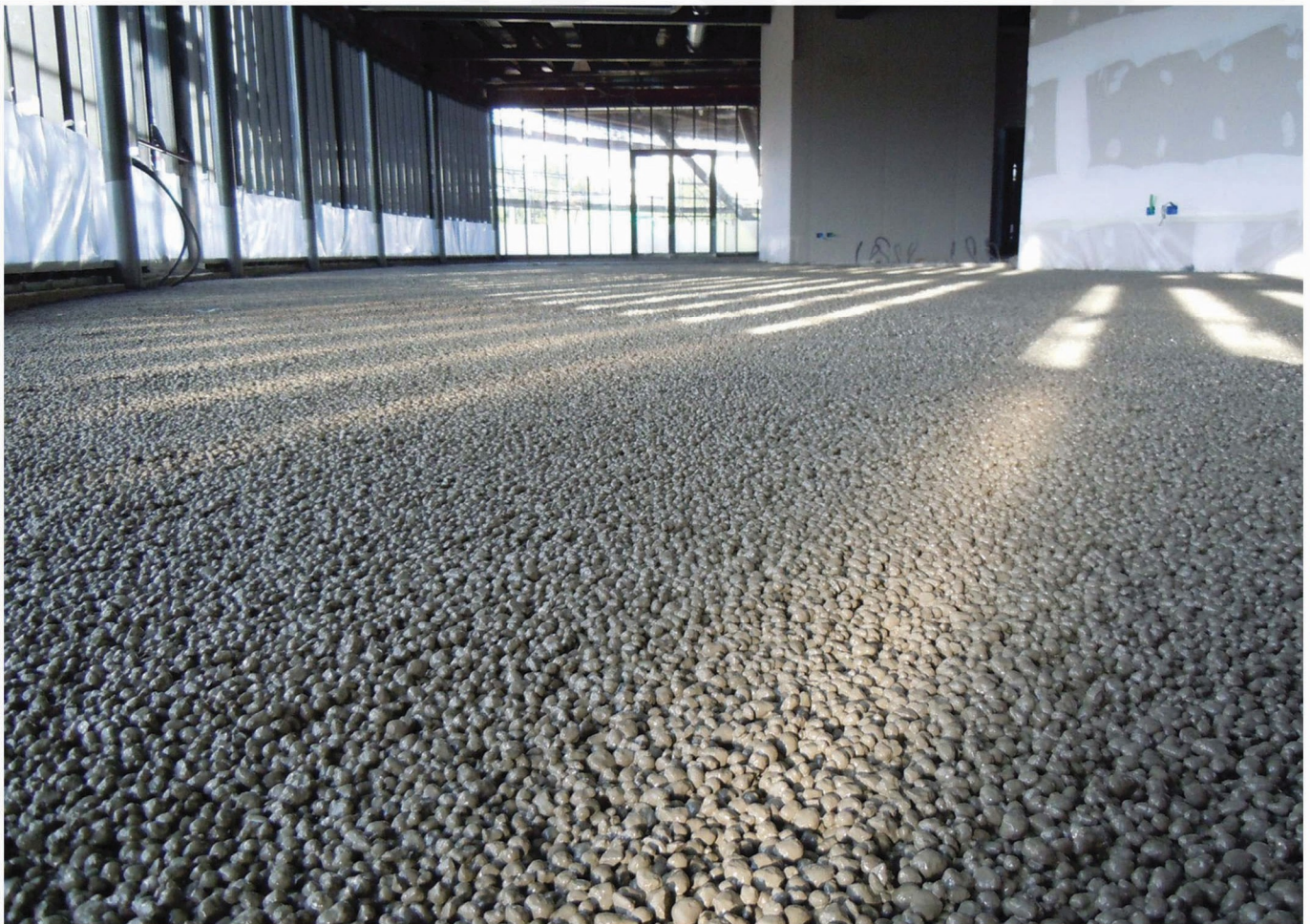
پروژه ه کفسازی و شیب بندی با پوکه صنعتی لیکا
