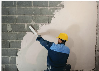
گچ کاری مستقیم روی بلوک حذف کامل سیمانکاری
